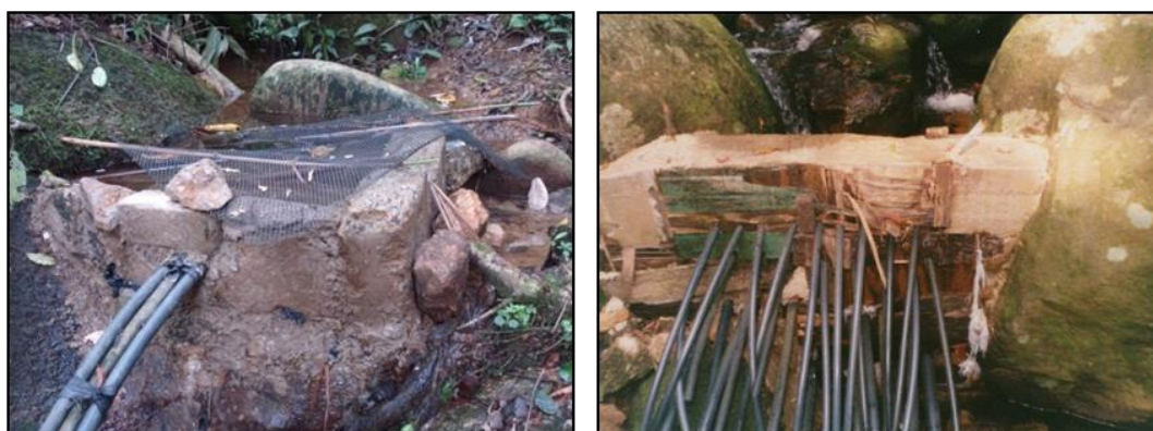
Figura 10 - Imagens de captações alternativas com mangueiras na UGRHI 3.
